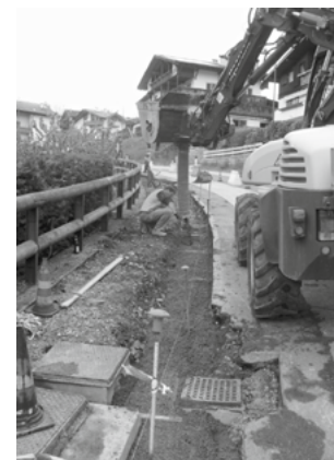
rifacimento del marciapiede di via Stazione a castello
